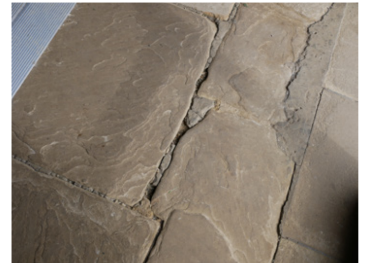
P36 Porch floor
